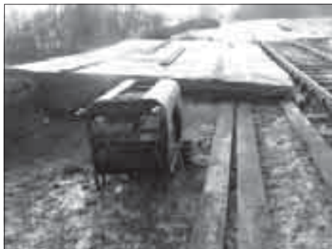
Бетонная канструкцыя віядука забяспечаная палаткамі
